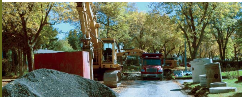
Une réfection complète pour l'avenue d'Anjou.
